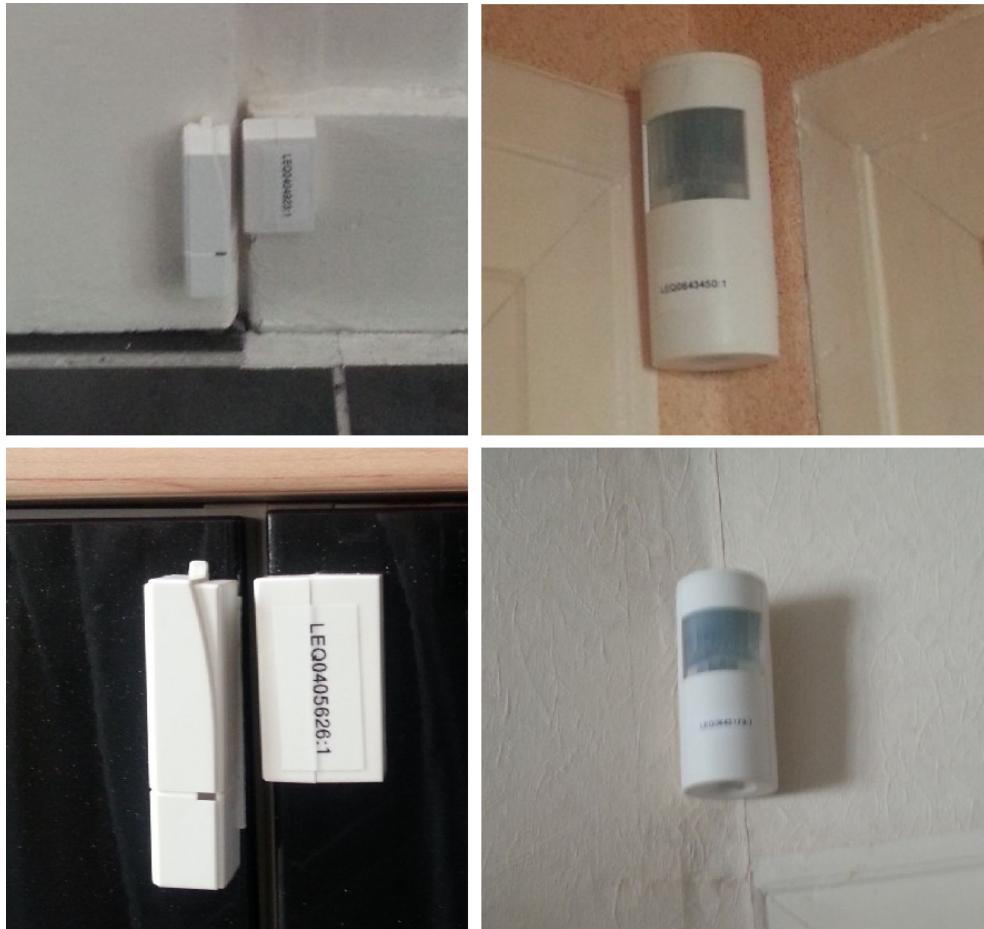
Abbildung 3.11: Exemplarische Anbringung der HomeMatic Bewegungsmelder und Magnetkontakte
